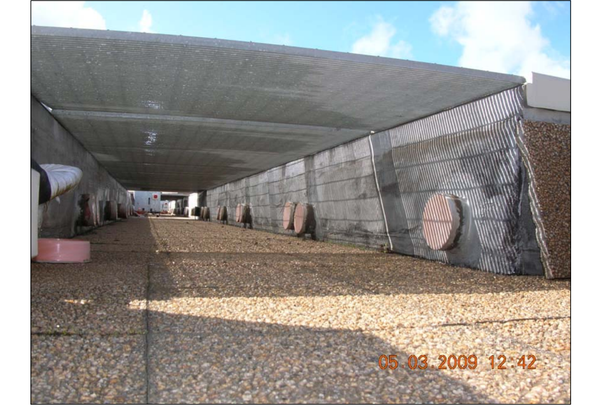
Particolare Copertura (Bocchette collegate con intercapedine pareti)
