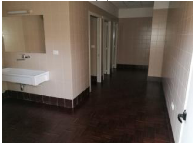
Particolare dei servizi igienici del lotto 1
