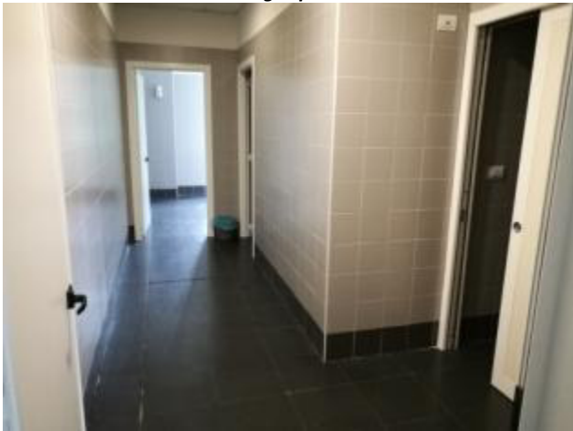
Particolare dei servizi igienici del lotto 2
