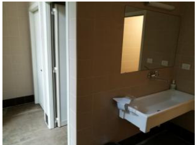
Particolare dei servizi igienici del lotto 4
