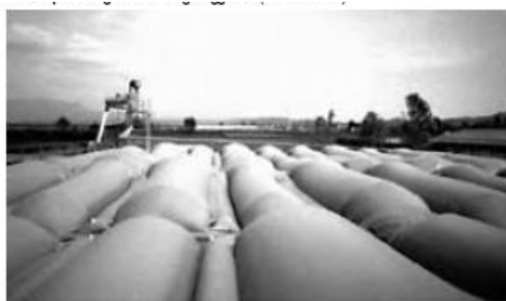
Figura 4.2 - Copertura gasometrica galleggiante (fonte CRPA)
