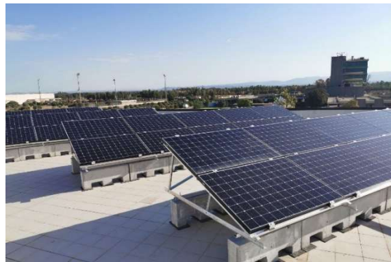
Figura 5: Campo fotovoltaico da 25 kW p in Si-monocristallino.
