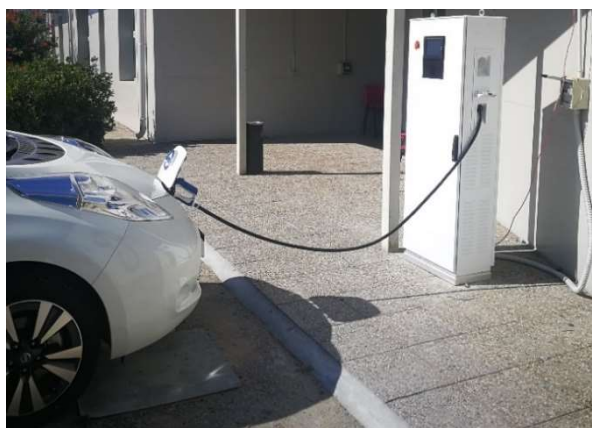
Figura 11: Colonnina di ricarica in DC abilitata per il V2G collegata alla Nissan Leaf
