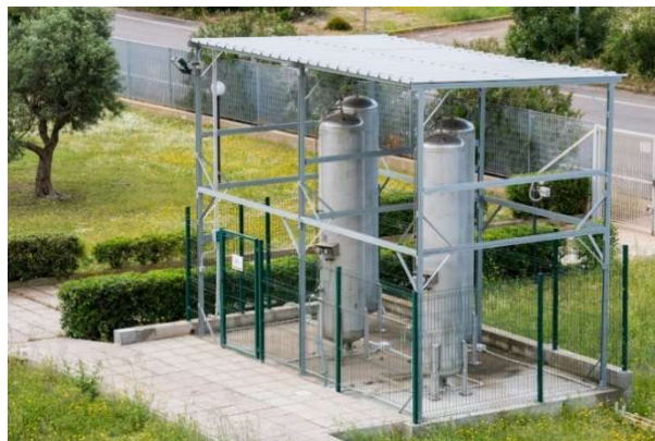
Figura 16: Serbatoi per l'accumulo di idrogeno in fase gassosa ( 51 \text{ Nm}^3 da 1 a 13,8 barg).
