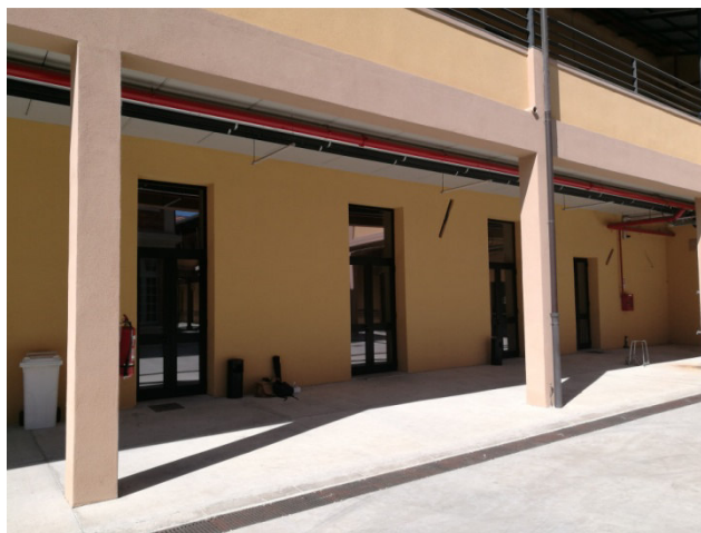
Accesso alla Corte 2 e spazio esterno
