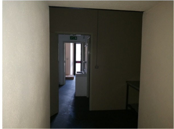
Accesso allo spogliatoio e servizi personale
