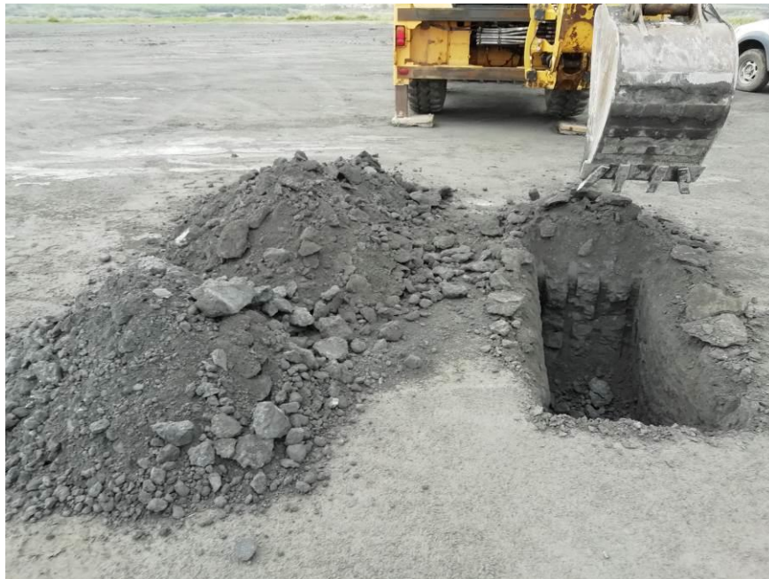
Immagine 3 - Prelievo di materiali per esperimenti di carbonatazione e riuso (Cortoghiana - Carbosulcis)
